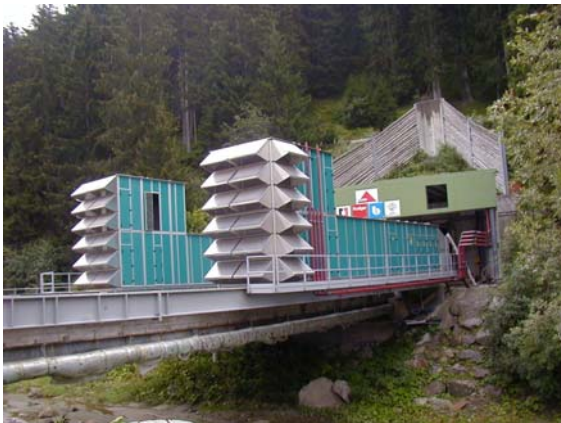
TRASCOCO Sedrun, 2 x 160 000m 3 /h, je 1500 kW Elektro + 3000 kW Vorwärmung mit Kälte- und Bergwasser
